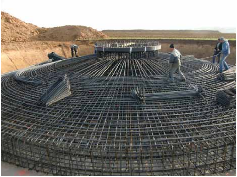
Armierungsarbeiten für das Stahlbetonfundament einer VESTAS V 90 am Standort Mainstockheim (Quelle: VOLTA Windkraft GmbH)
